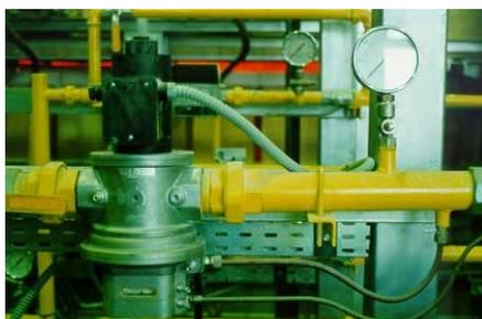
Figura 5-6: Válvula de regulação
