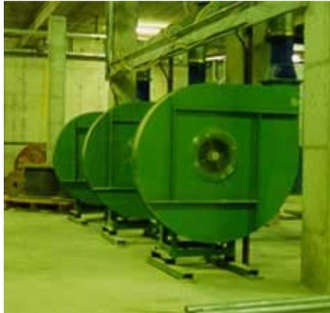
Figura 5-9: Ventiladores da câmara de fusão
